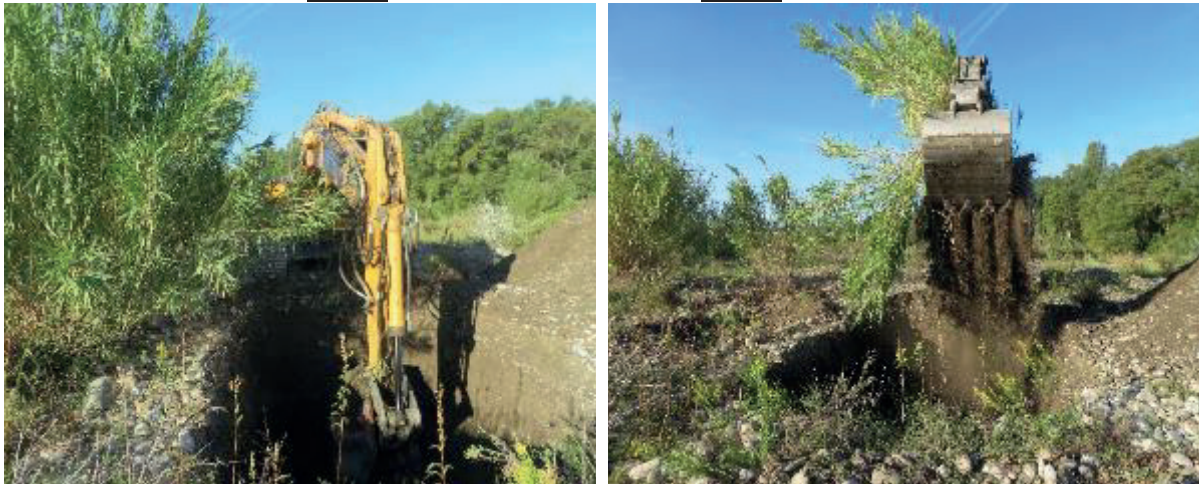
Exemple de fosse pour l'enfouissement des espèces invasives – Source : ECOTER
